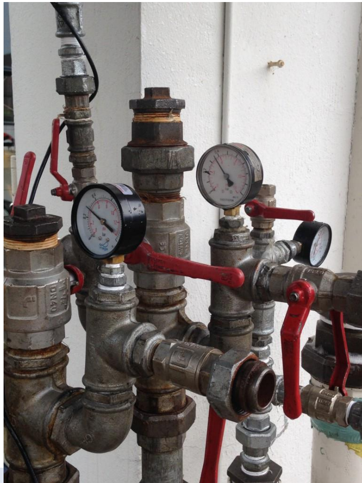
Foto 15: Op dichtheid te beproeven installatie.
